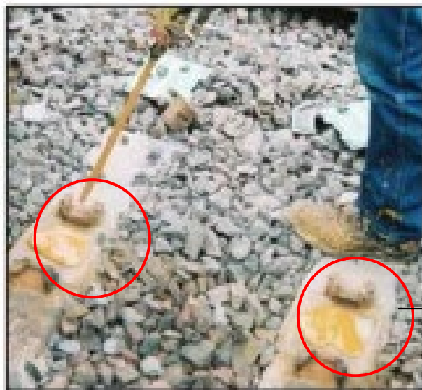
Figura 25- Aplicação de poliuretano de reparo em áreas danificadas no dormente de concreto
